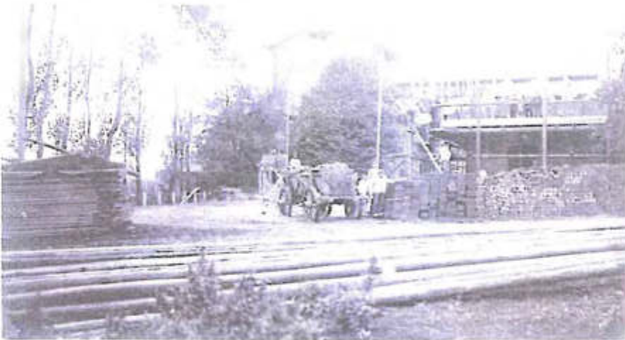
Dieses Bild zeigt den Bau des Kornspeichers 1916/17
