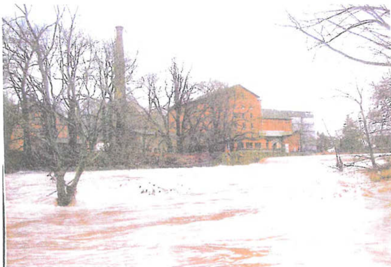
Hochwasser im Januar 2003 Aufnahme NW
