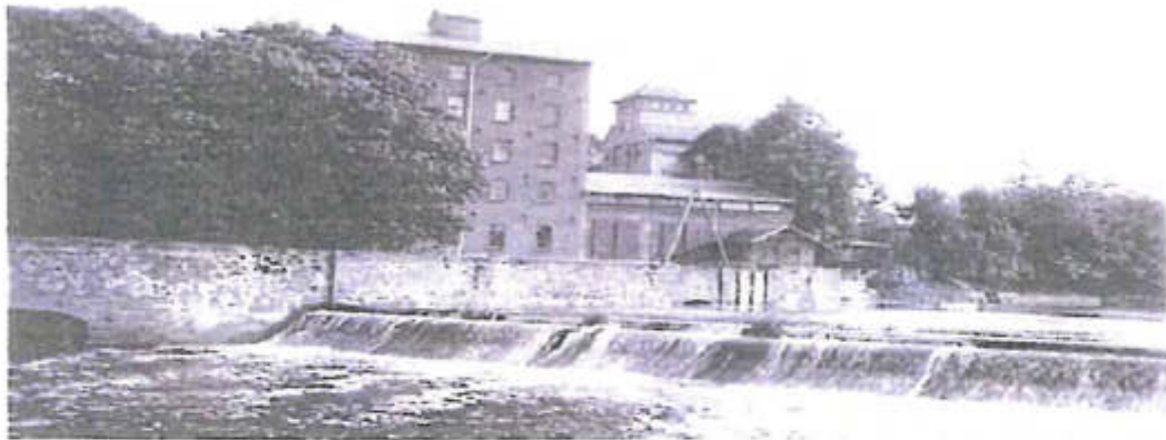
Diese Aufnahme von der Werreseite um 1950 zeigt das Wehr, das Mühlenhaus, das Turbinenhaus und das Kornsilos, gebaut 1916 Privatfoto F. Fischer
