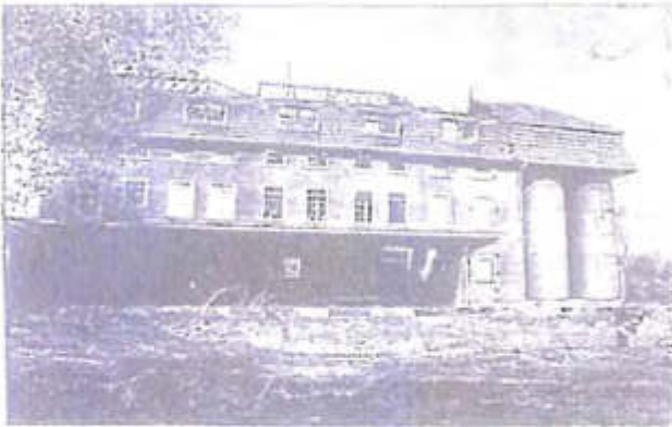
Die ausgebrannte Roggenmühle vor dem Abriss 1988
