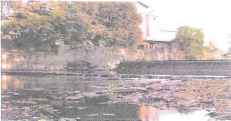
Das Stauwehr der Werre. Sommer 2003. Aufnahme der NW
