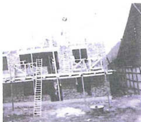
Das alte Fährhaus wurde 1963/64 abgerissen, nachdem ein neues Wohnhaus auf etwas höherem Grund daneben gebaut worden war. Foto F. Fischer
